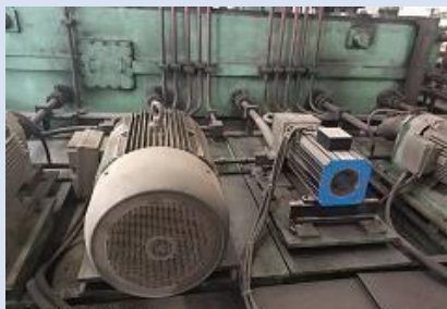
電機改造：左側為改造前，右側為改造後
