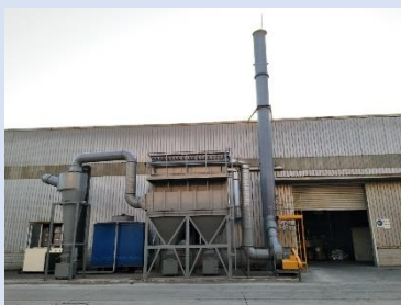
上海生產車間和實驗室改造末端處理設備
